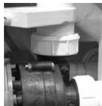
Vanne guillotine et raccord-union de la pompe
